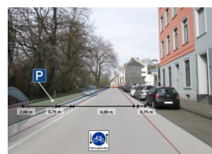
Rütcher Str. (Höhe ehem. Bunker)
