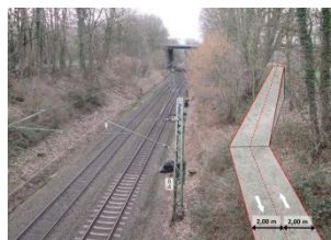
Bahnstrecke AC-D'dorf (Blickrichtung Richterich)
