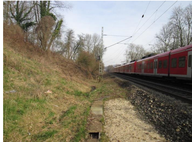
Abb. 70: Brücke Pilgramsweg (Einschnittböschung)
