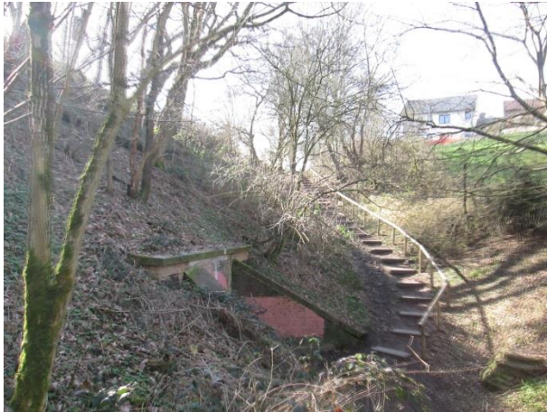
Abb. 69: Auf den Heggen (Fußgängertunnel)
