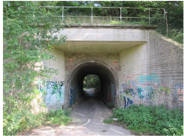
Abb. 100: Postropsweg, Bestand (Tunnel zum Wurmtal)
